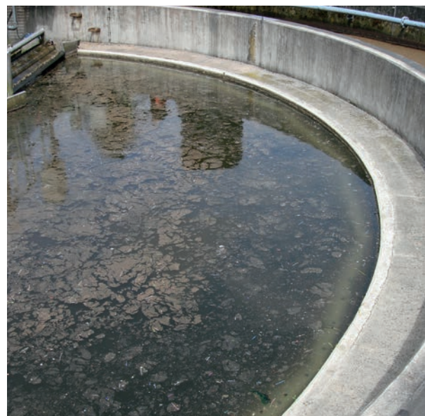
Plastik im Kläranlagenablauf nach einem Starkregenereignis
